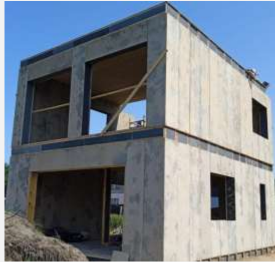
19 pav. „Shellbau“ perdangos montavimas
