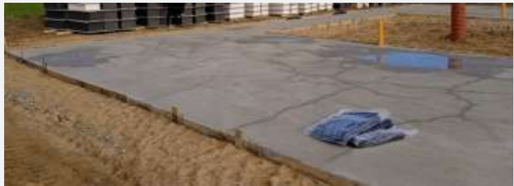
1 pav. Plokštuminiai pamatai
