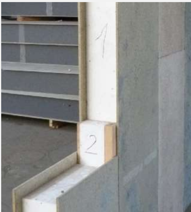
27 pav. Plokščių sujungimo mazgas
