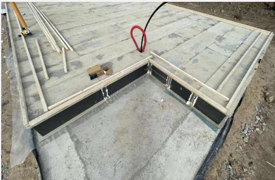
3 pav. Pamato plokščių jungimas
