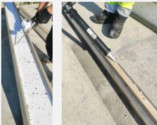
4 pav. Shellbau plokščių sandarinimas
