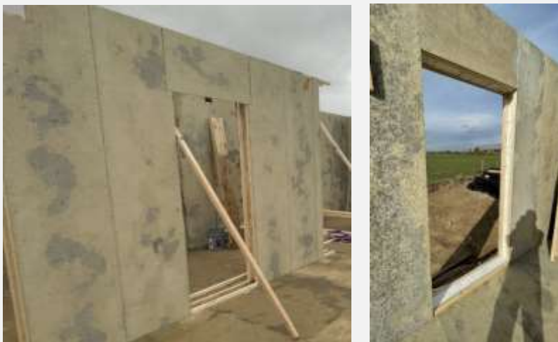
7 pav. Sieninių plokščių montavimas
